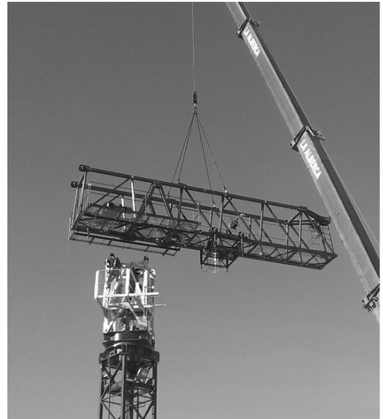
Führen Sie das Teilstück 1 des Auslegers zusammen mit dem Monteur, der sich auf der Trittplatte des Kabinenstücks befindet, an die Laschen der Drehbühne heran, bis Teilstück 1 in diese Laschen fasst.
