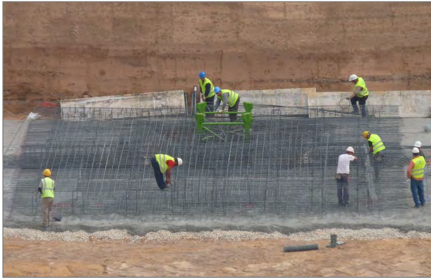
Abbildung 9.- Detailansicht des Gestells der Fundamentplatte des Krans
