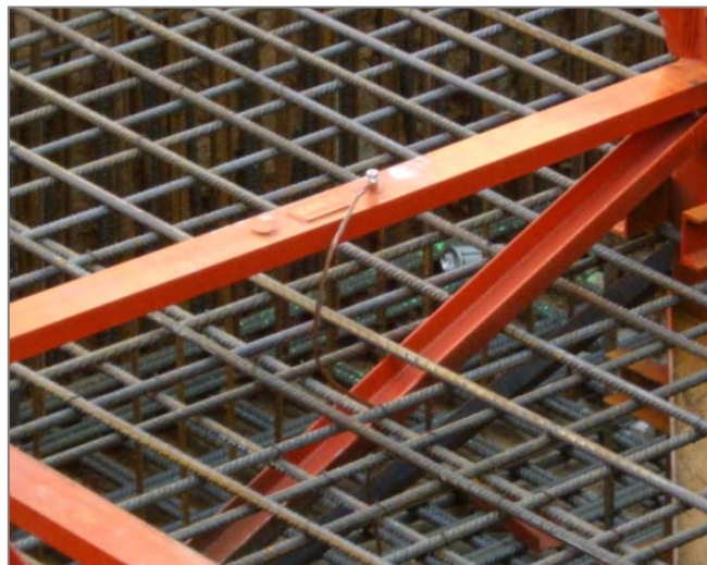
Abbildung 6.- Detailansicht der Erdung des Einbaustücks mit einem blanken Kupferkabel.
