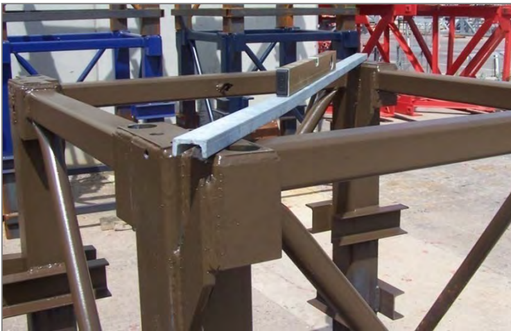
Abbildung 4.- Überprüfung der Nivellierung in beide Richtungen (diagonal)
