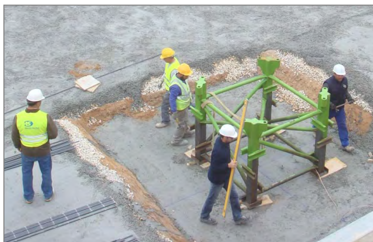
Abbildung 2.- Nivellierung des Einbaustücks
