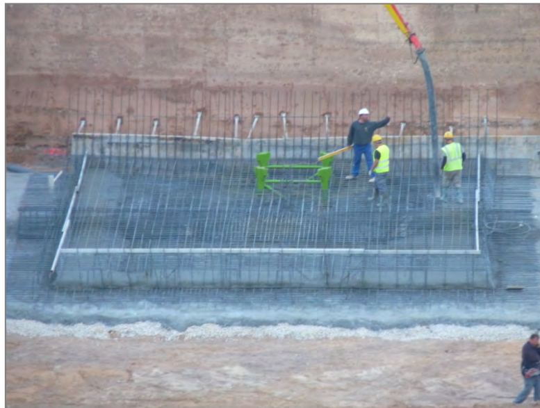
Abbildung 11.- Auffüllen der Fundamentplatte mit Hilfe einer Betonpumpe
