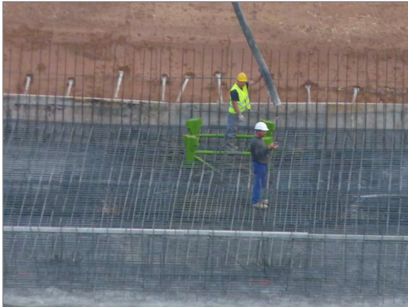
Abbildung 10.- Detailansicht der Montage des oberen Gitters
