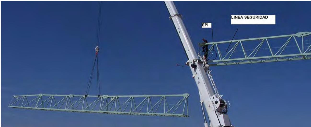
**Es ist ratsam, die Auslegerelemente zur Erleichterung der Montage mit einem Seil zu führen.**
