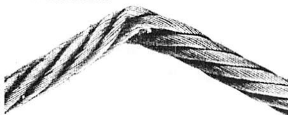
Fig. 8 - Pli résultant d'une action mécanique sur le câble
