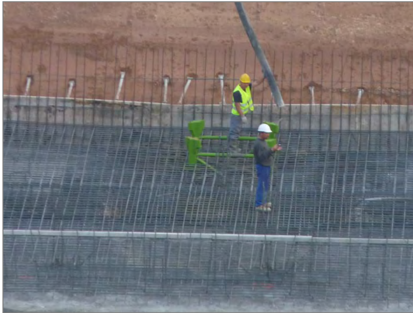
Abbildung 10.- Detailansicht der Montage des oberen Gitters
