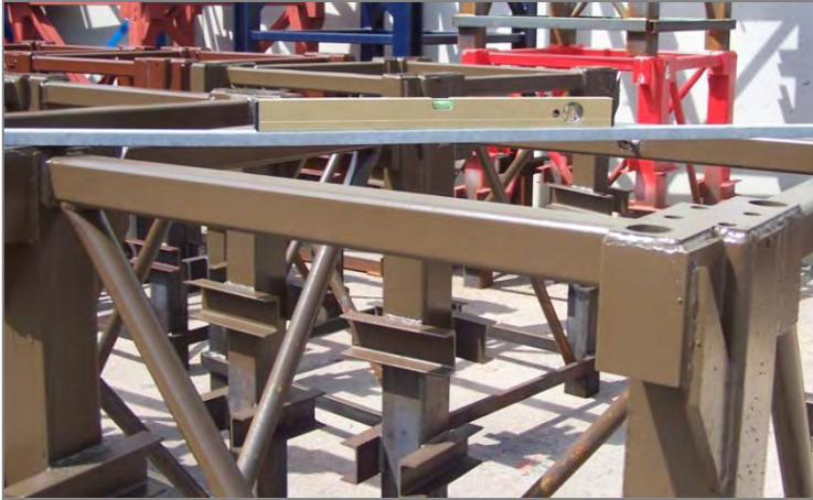
Abbildung 3.- Überprüfung der Nivellierung in beide Richtungen (diagonal)
