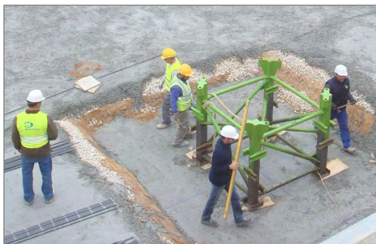
Abbildung 2.- Nivellierung des Einbaustücks
