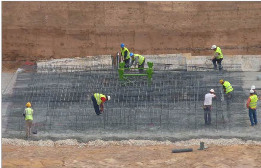
Abbildung 9.- Detailansicht des Gestells der Fundamentplatte des Krans
