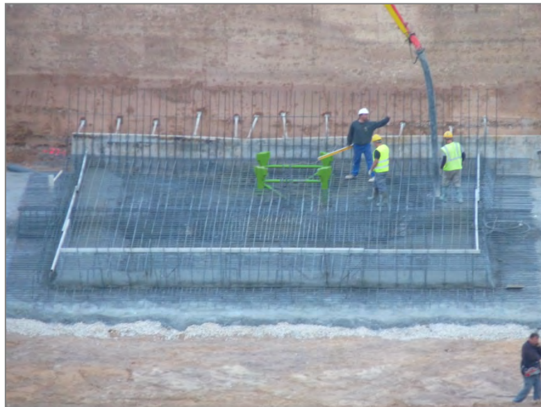
Abbildung 11.- Auffüllen der Fundamentplatte mit Hilfe einer Betonpumpe
