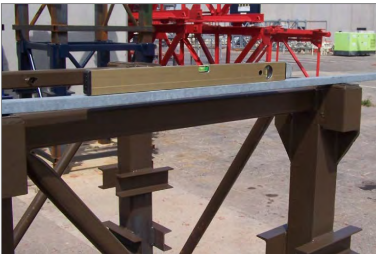
Abbildung 5.- Überprüfung der Nivellierung der vier Stützen des Einbaustücks
