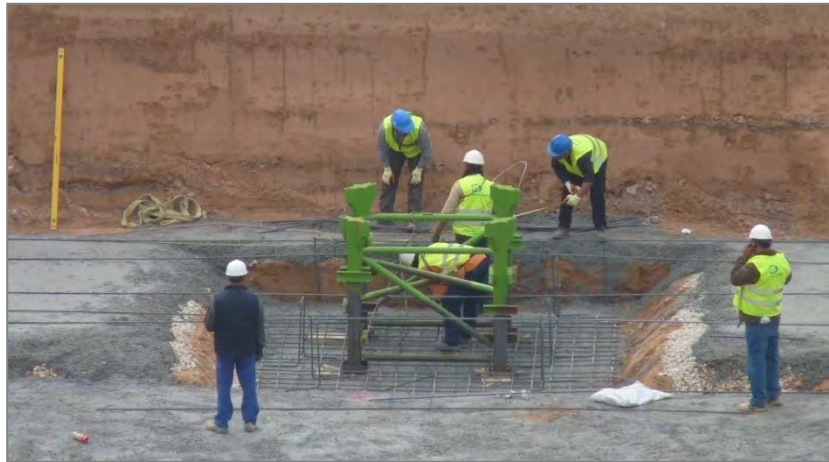
Abbildung 8.- Detailansicht der Montage der Gitter über dem Einbaustück
