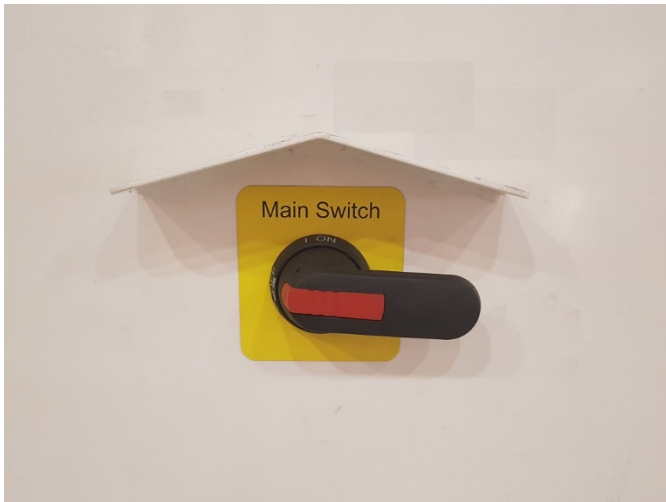
21. EIN-/AUS-Schalter des Schaltschranks
