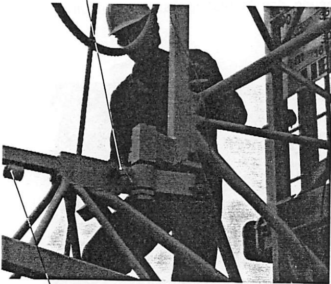
Lagerhülse für Obergurtverbindungsbolzen
